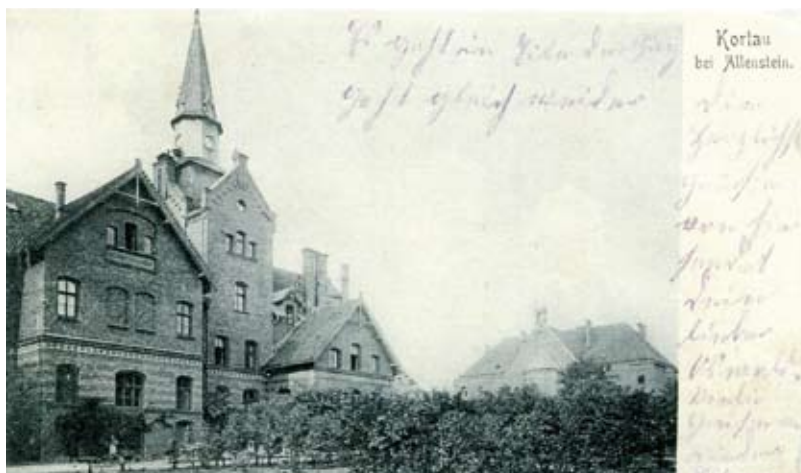
Budynek gospodarczy i administracyjny ok. 1903 r. Dziś nie istnieje. Obecnie plac Cieszyński i ul Licznarskiego
