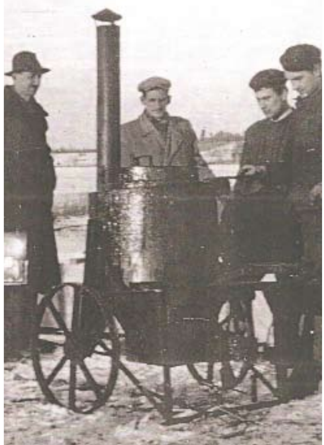
Beczka rozgrzewająca smołę (od lewej P.Olszewski, A. Tadajewski i żołnierze pomagający w smolowaniu rurociągu. 1956 r.
