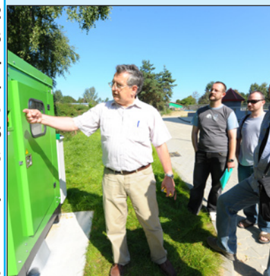
Budowa RCI zakończona (str. 3)
