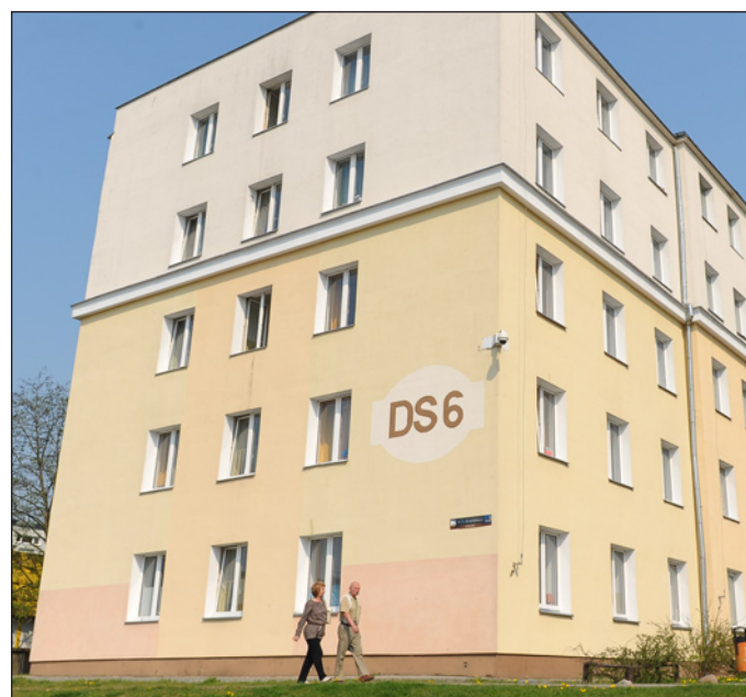
Do końca wakacji dziewięć akademików przejdzie remont
