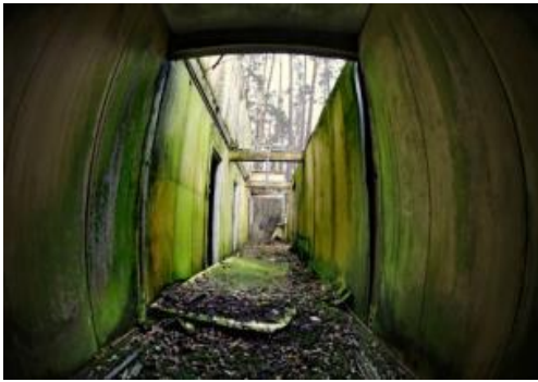
Fot. 5. Pozostałości po dawnym ośrodku wypoczynkowym w Rudziskach Pasymskich, gmina Pasym, fotografia własna, marzec 2012 r.
