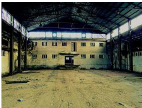
Fot. 4. Ruiny dawnej zabudowy przemysłowej na terenie Olsztyna, fotografia własna, grudzień 2013 r.
