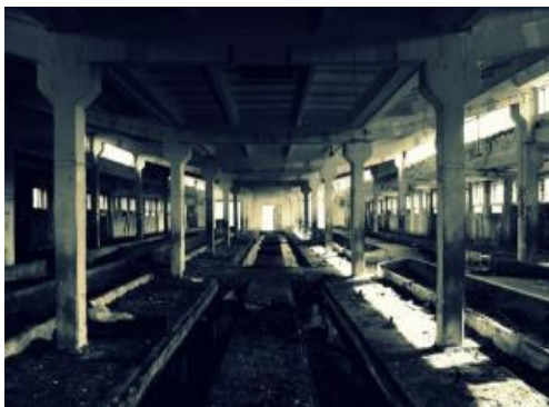
Fot. 3. Ruiny dawnych budynków gospodarczych w gminie Gietrzwałd, fotografia własna, kwiecień 2013 r.
